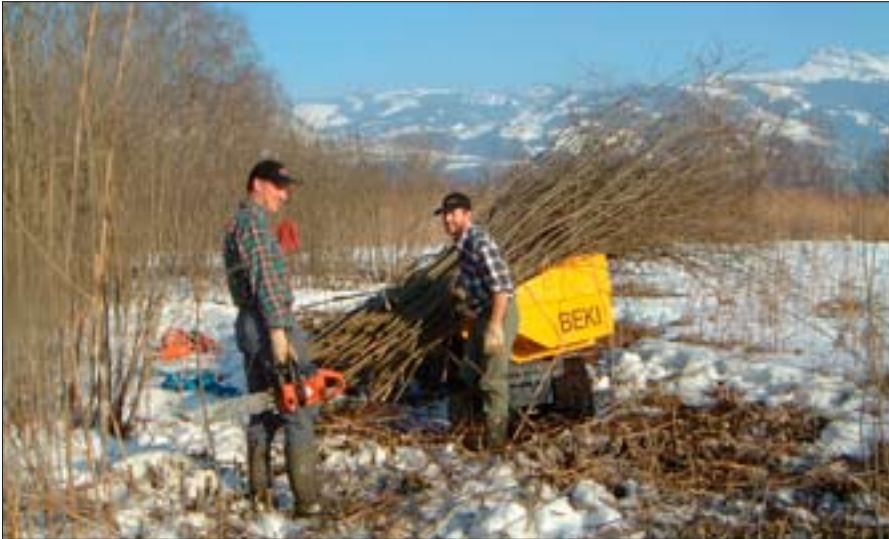
Geschnittene Weidenruten aus der Südwestecke des Entensees wurden für die Herstellung von Faschinen zum Schutz der Bätzimattinseln verwendet (Foto: K. Robin).
