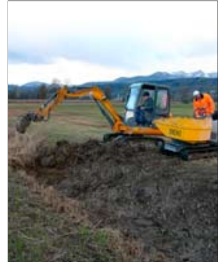
Die Bewässerungsgräben des Reservats sind nachgegraben worden (Foto K. Robin).
